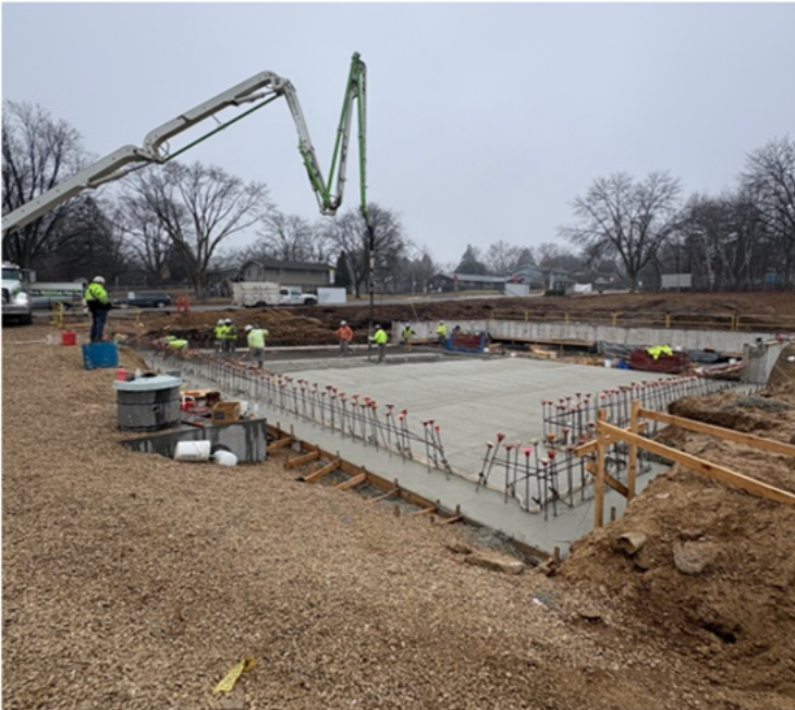
Badger pouring the final pool floor pour!
